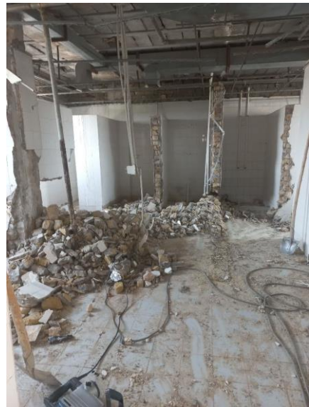
تخریب و برچیدن تیغه ها و جمع آوری لوله های فاضلاب چدنی
