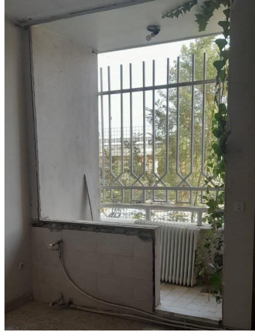
برچیدن پنجره های آهنی و آماده سازی جهت نصب پنجره دوجداره
