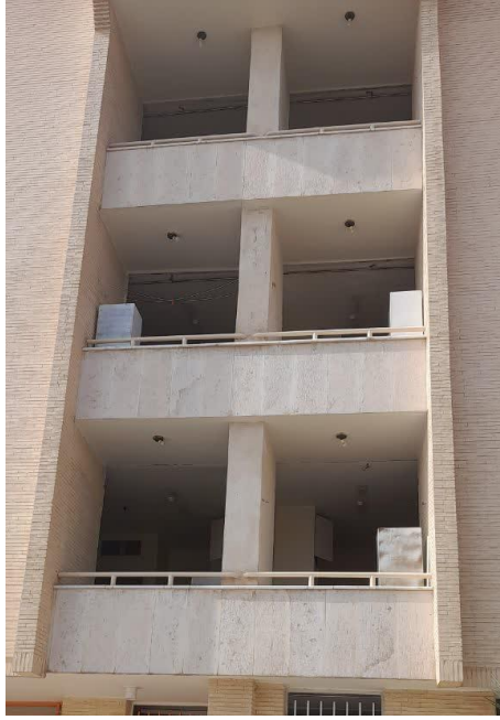
برچیدن پنجره های آهنی و آماده سازی جهت نصب پنجره دوجداره
