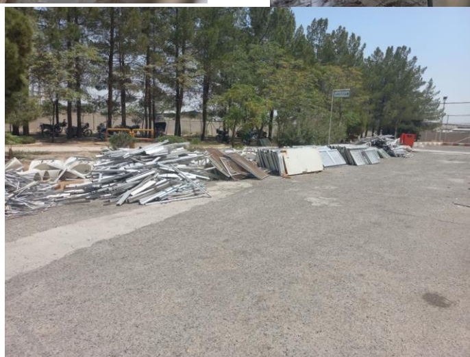
برچیدن سقف های کاذب، شیرآلات، درب ها و سایر ملزومات نصبی در سرویس های بهداشتی و پنجره اتاقها
