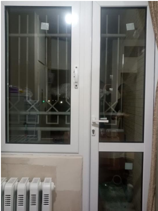
نصب درب و پنجره دوجداره در اتاقها و راهروها
