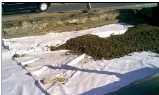
شکل ۳: استفاده از ژئوتکستایل برای جداسازی خاک
