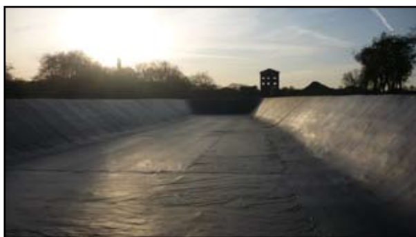
شکل ۴: استفاده از ژئوممبرین برای آب بندی کف کانال
